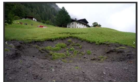
Der ca. 10 x 10 Meter und ca. 3 Meter tiefe Krater
