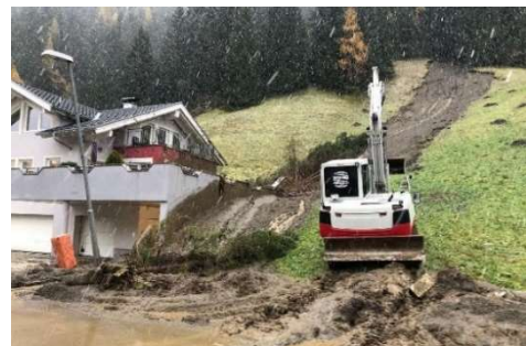
Bild des Einsatzortes
