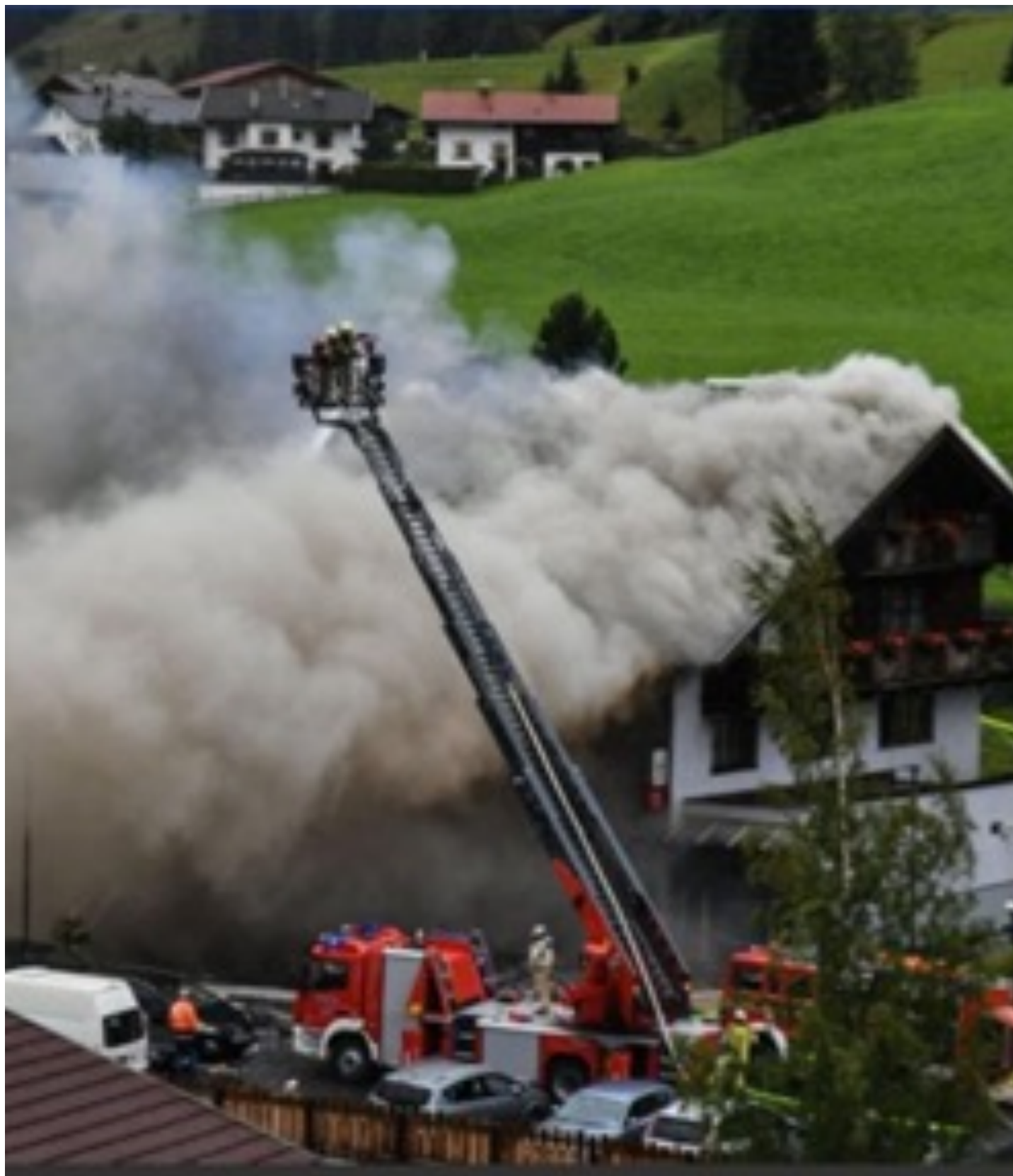
Das Gebäude nach der Explosion
