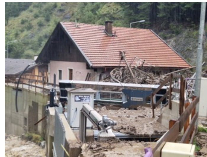
Wasserkraftwerk der Gemeinde Gries
