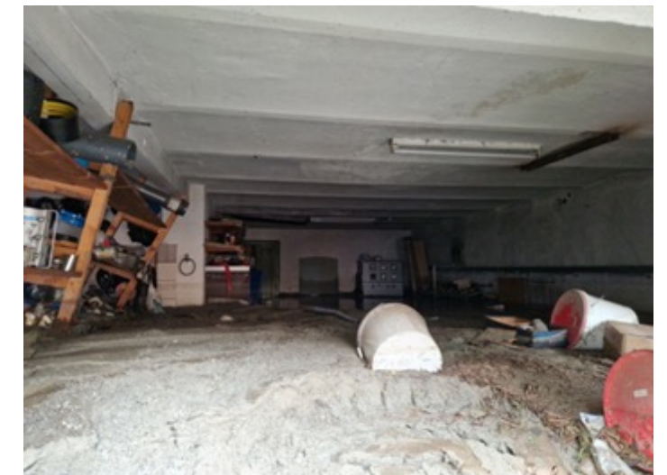
Altes Kraftwerk (Lagerraum)
